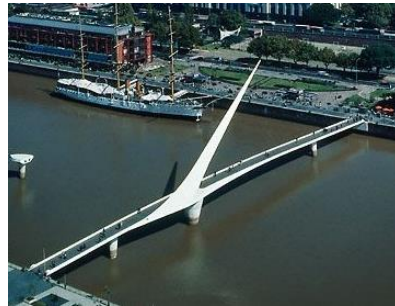
Puente de la Mujer Bridge
