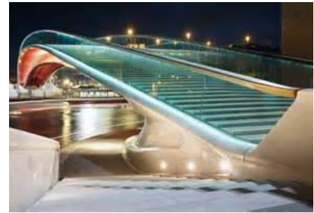
Ponte della Costituzione Bridge
